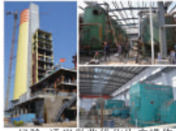
合成氨系统优化平衡改造项目有拆有建
